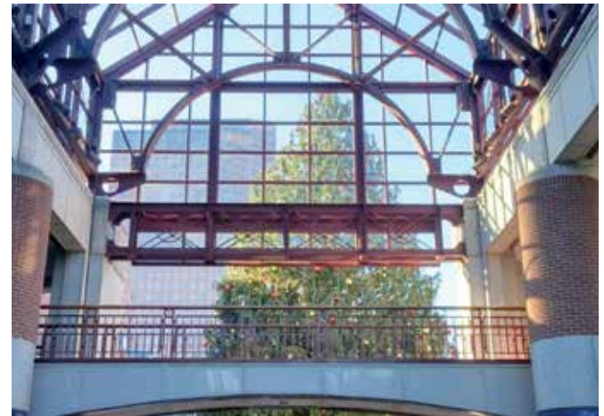
2014'teki inceleme, Marketplace Center'ın dubleks kaplama sisteminin hala mükemmel durumda olduğunu gösterdi.
