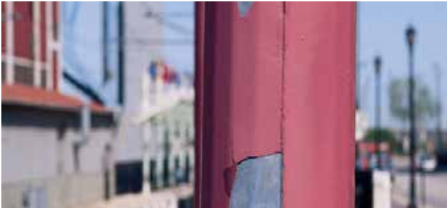
DUPLEX sistemler - Galvanizden boya kalkması
